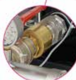
Clapet anti retour laiton et raccord union 3 pièces démontable en inox 316 étanchéité cône-cône
